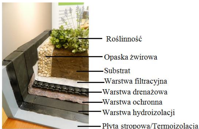
Rysunek 10. Przykładowy układ warstw na zielonym dachu
