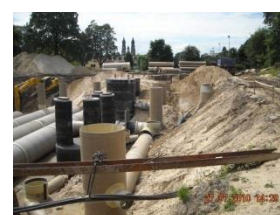
budowa sieci kanalizacyjnej, źródło: http://wuprinz.pl/pliki/get/pliki/realizacje/wo_dociagi%20i%20kanalizacje odczyt: 27.03.2019
