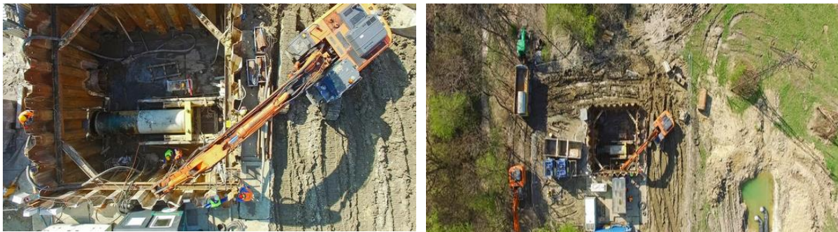
Rysunek 15 Technologia mikrotunelowania
