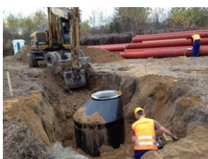
studnia DN 1200 z regulatorem przepływu, źródło: http://kanbud.eu/kanalizacja-deszczowa odczyt: 27.03.2019
