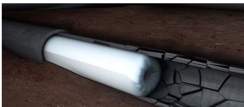
Rysunek 17 Renowacja rurociągu z zastosowaniem "rękawów" (CIPP)
