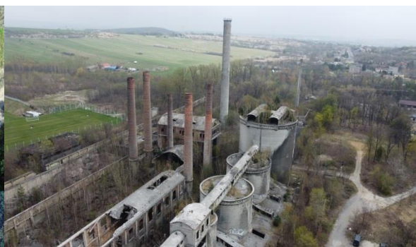
Fot. 2. Przykłady obiektów infrastruktury technicznej występujących na terenach przemysłowych
